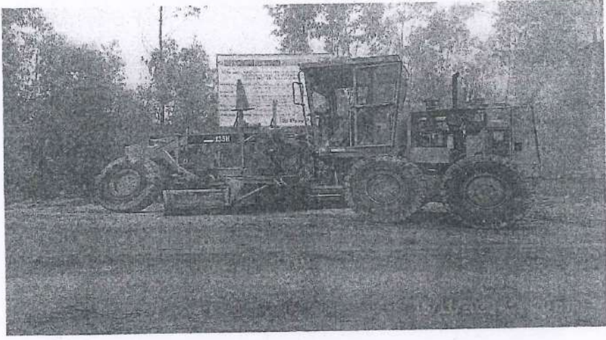
Fotografía 6. Trabajos de escarificado desde la progresiva Km 00+000 hasta la progresiva Km 00+500.
