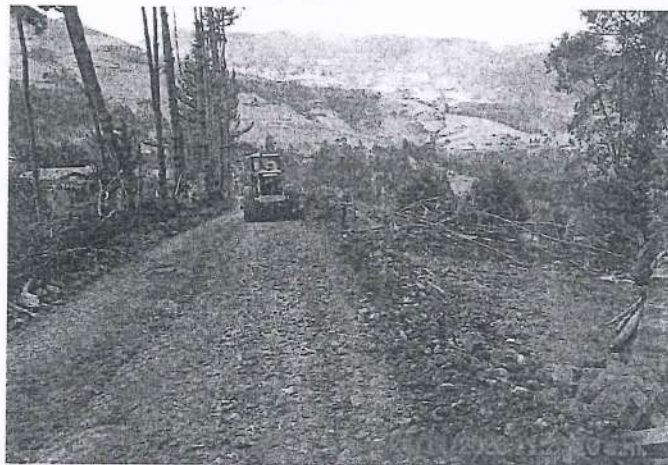
Fotografía 20. Rodillo realizando trabajos de compactación en la vía.
