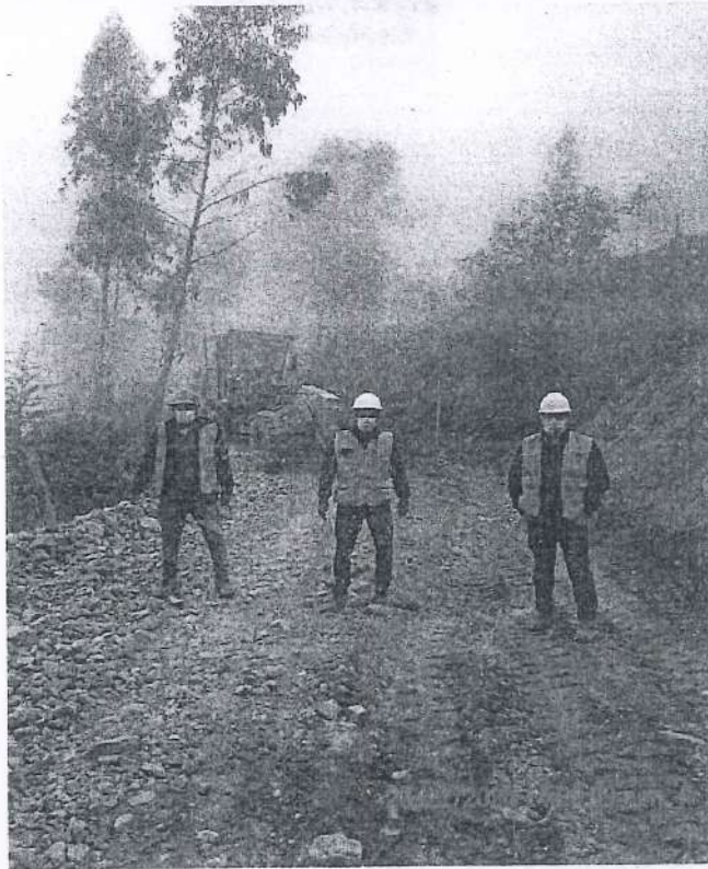
Fotografía 26. El inspector verificando los trabajos que se viene realizando.
