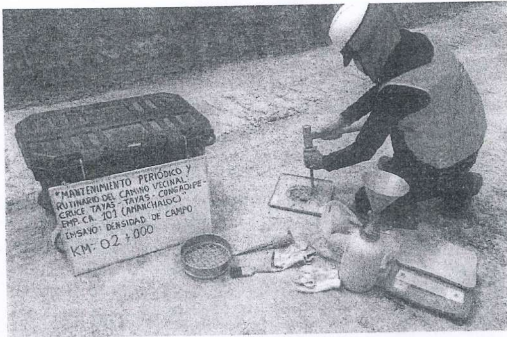
FIGURA 9. Ensayo de Densidad de Suelo en Campo en la progresiva Km 02+000
