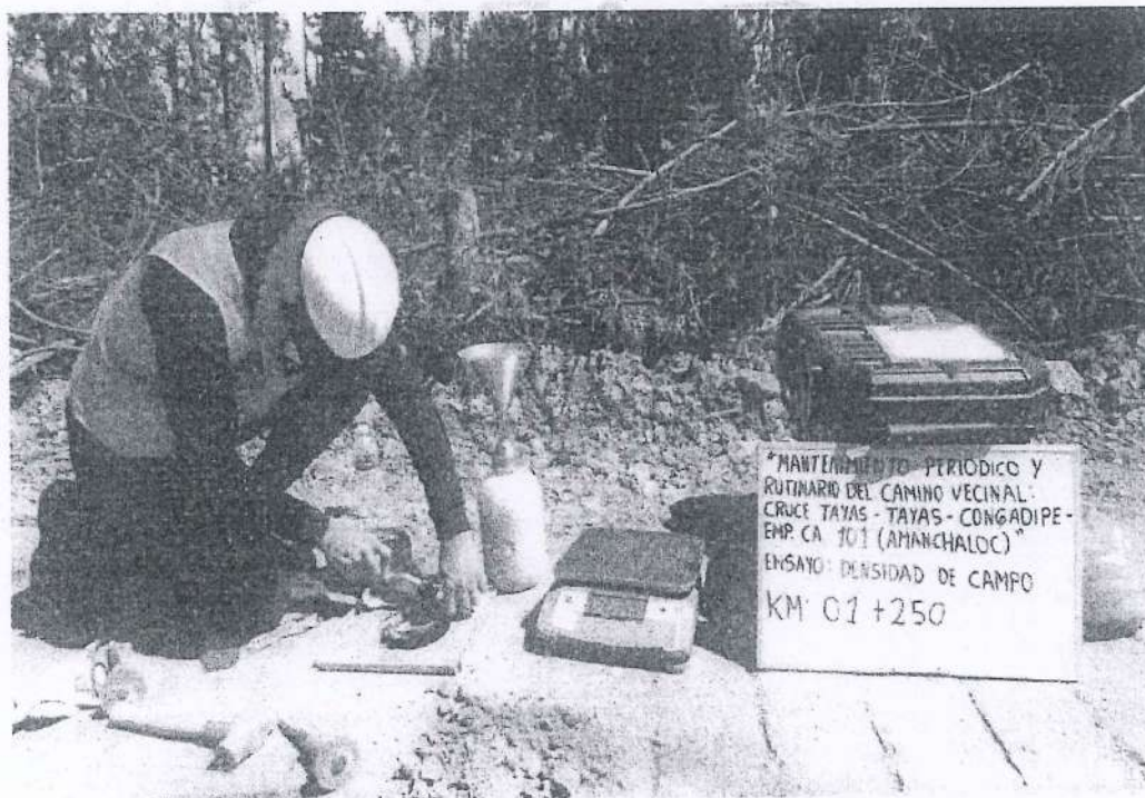
FIGURA 6. Ensayo de Densidad de Suelo en Campo en la progresiva Km 01+250
