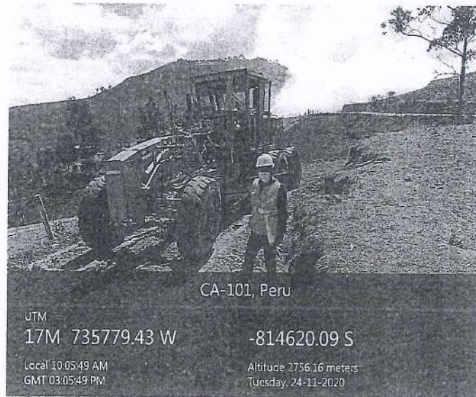
Fotografía 21. Motoniveladora realizando trabajos de extendido de material granular en la vía.
