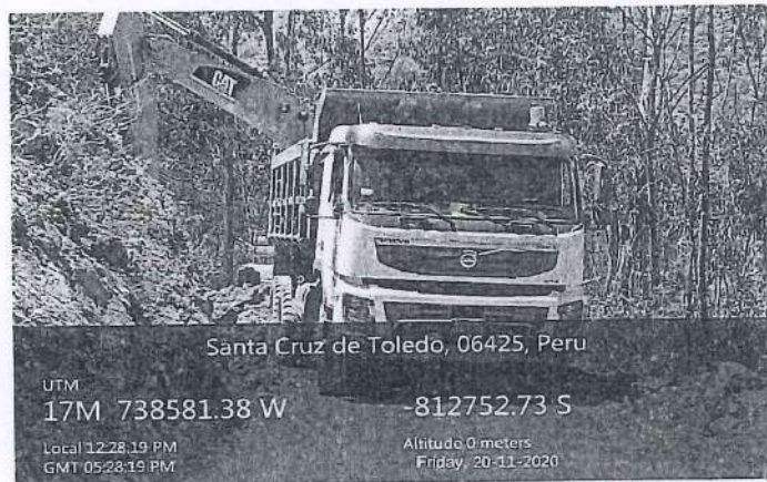
Fotografía 7. Carguío de material granular para afirmado.
