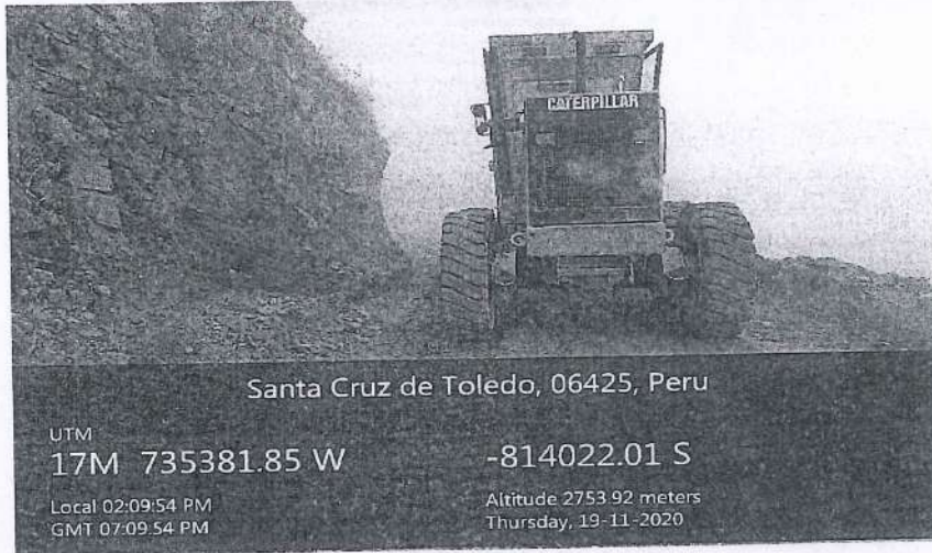
Fotografía 10. Motoniveladora realizando trabajos de escarificado de la vía.
