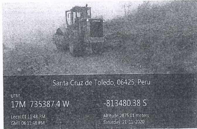
Fotografía 6. Rodillo realizando trabajos de compactación en la vía.
