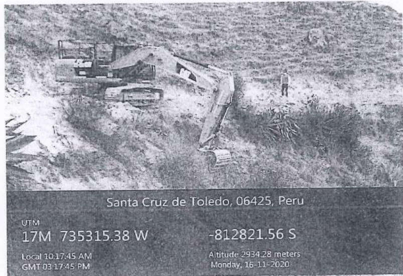
Fotografía 3. Movilización de la excavadora de orugas 320D 2L, hasta puntos críticos identificados con el fin de ampliar la vía para dar acceso a vehículos pesados
