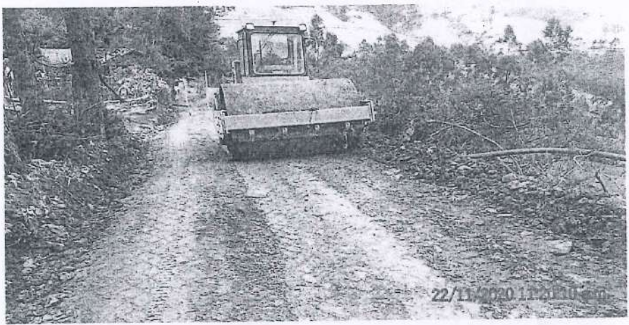
Fotografía 17. Rodillo realizando trabajos de compactación en la vía.
