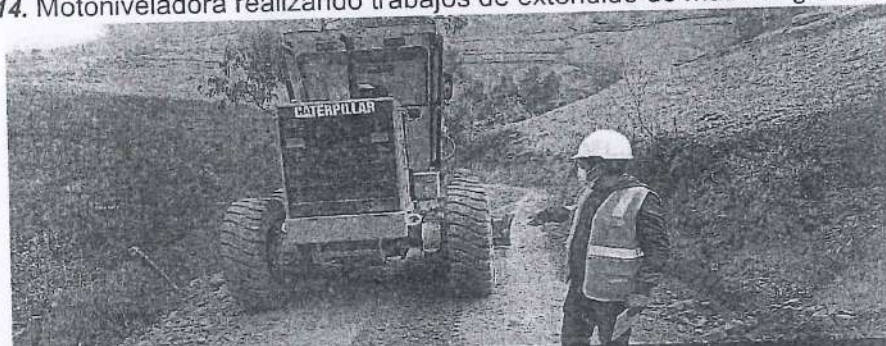
Fotografía 14. Motoniveladora realizando trabajos de extendido de material granular en la vía.
