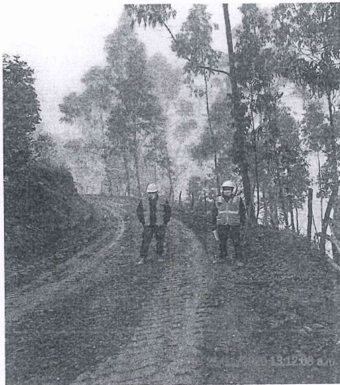
Fotografía 27. El inspector verificando los trabajos que se viene realizando.
