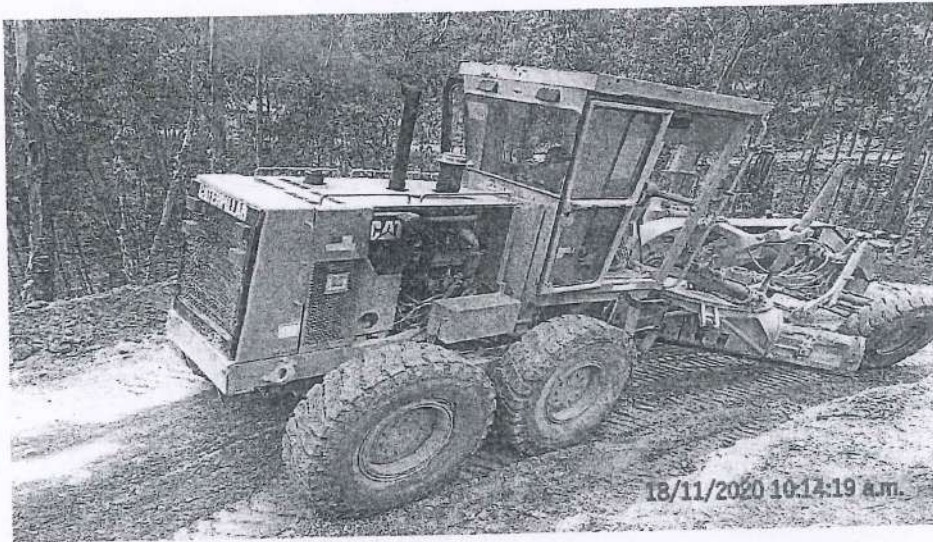
Fotografía 8. Motoniveladora realizando trabajos de escarificado de la vía.
