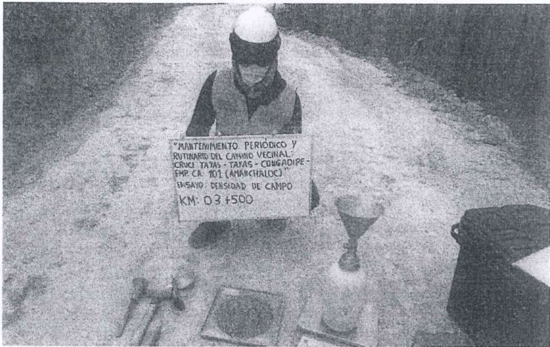
FIGURA 15. Ensayo de Densidad de Suelo en Campo en la progresiva Km 03+500
